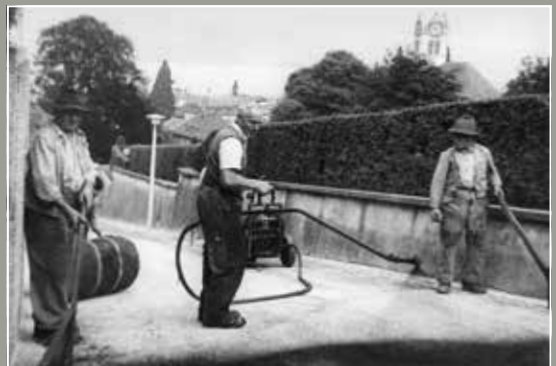
Strassenbauarbeiten in den 1950er-Jahren: an der unteren Löwengasse, am Kirchrain und an der Kreuzung Zugerstrasse/Heubachstrasse.
