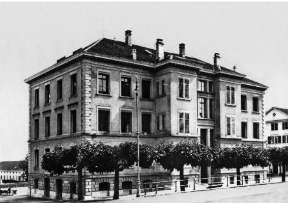
Sekundarschulhaus (links), Pausenplatz mit Turnhalle (rechts), 1950.
