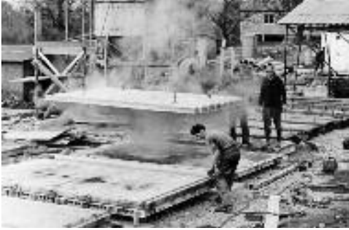
Vorfabrikation von Elementen
