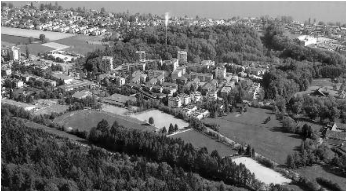
Aktuelle Flugaufnahme der ge- bauten Schul- und Sportanlage
