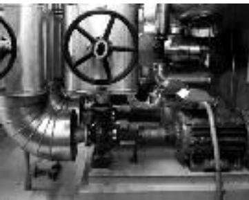
Fernwärmezentrale, Netzpumpen
