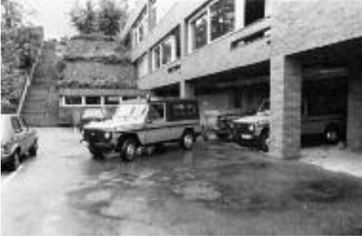
Das Strassenwesen war ehemals u.a. unter dem Kirchgemeindehaus und beim Hüenerbühl untergebracht.
