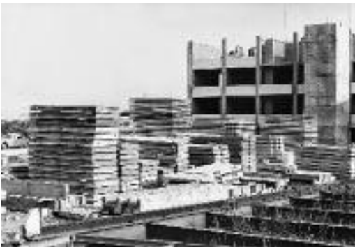
Elementlager auf der Baustelle
