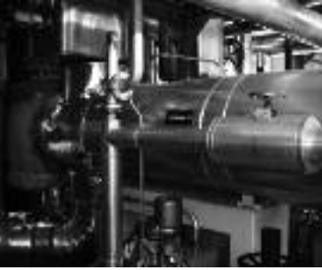
Fernwärmezentrale, Wärmetauscher
