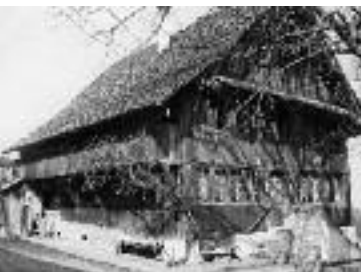
Das geschützte Wohnhaus Eberhard fiel im September 1979 einem Brand zum Opfer.
