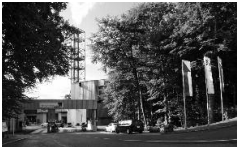
Zugang zum Kehrichtwerk von der Zugerstrasse aus
