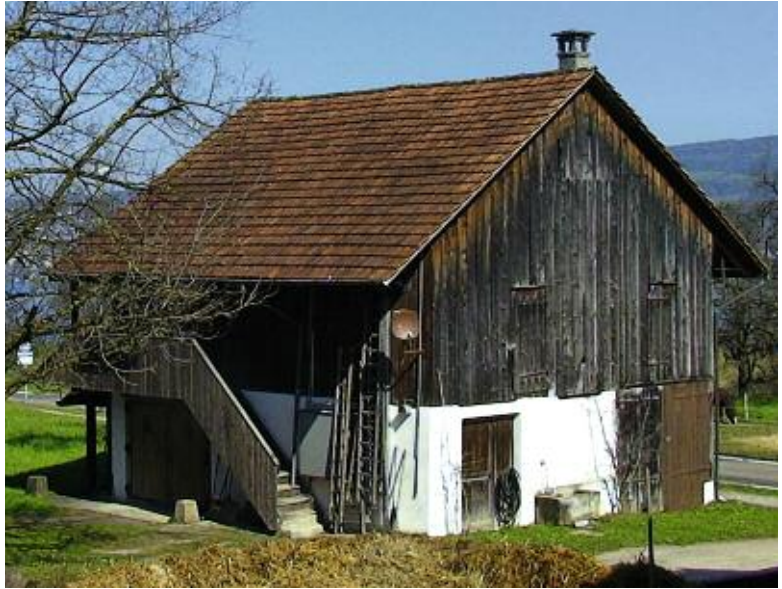
Umgebautes Waschhaus in der hinteren Rietwies, heute Rietwiesstrasse 102a, 2011.
