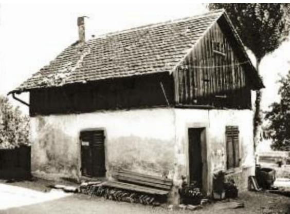
Das einstige Waschhaus von 1852 im «Hüsli», Tödistrasse 10, 1969. Rechts der mit Blumen geschmückte alte Waschkessel, 2011.
