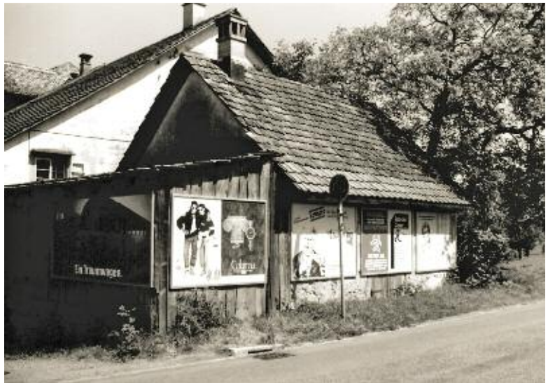
Waschhaus Einsiedlerstrasse 11a vor der Renovation, 1990.
