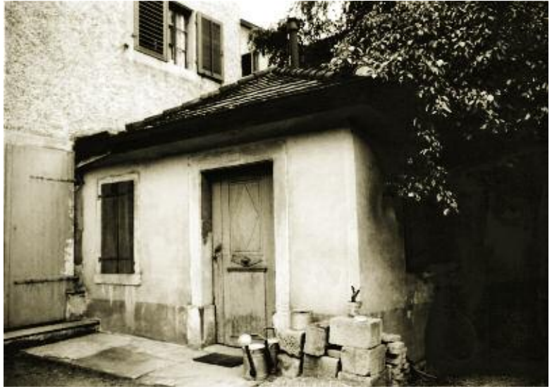
Ehemaliges, an das Wohnhaus angebautes Waschhaus an der Hirsackerstrasse.
