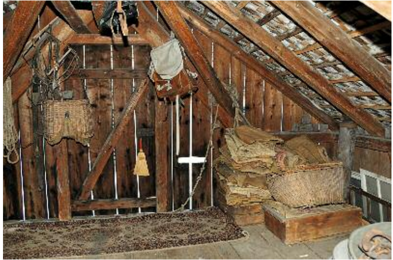
Dachraum des Waschhauses im «Hüsli», 2011.
