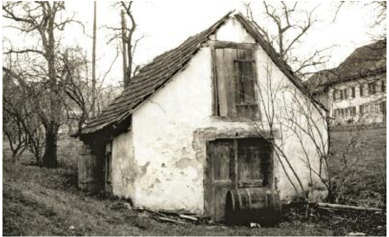
Waschhaus im Vorder Arn (heute umgenutzt), 1969.
