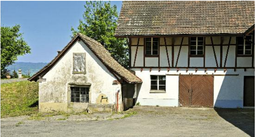
Oben: Zu Wohnzwecken umgebautes Waschhaus im Langacher, 2011.
