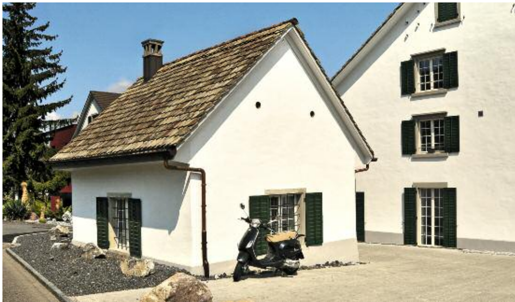
Waschhaus Einsiedlerstrasse 11a nach der Renovation, 2011.
