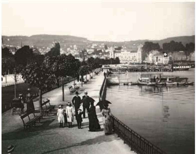
Im Juli 1887 wurden die Quaianlagen eingeweiht. Der Bau war eine der grossen städtischen Arbeiten, die unter der Leitung Arnold Bürklis ausgeführt wurden, um 1890.
