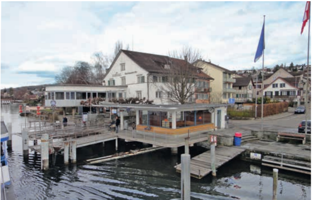
▲ Schiffswartehalle Erlenbach, 2011. Die Schiffswartehalle von 1939 mit dem Restaurant Schönau im Hintergrund.
