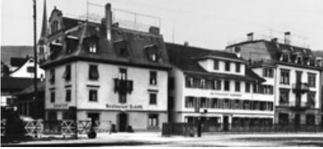
Bahnhofstrasse mit Restaurant Schiffl und Bahnhof, 1929 Rechts: Restaurant Schmiede, Käpfnach, 2008
