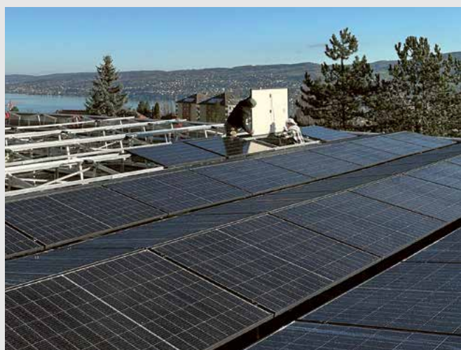
Bau der Solaranlage auf dem Dach des Feuerwehrgebäudes (Solarbeteiligungs-Projekt)
