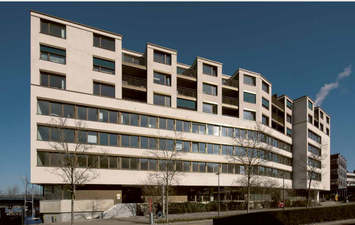
Sanierung und Aufstockung Hotel Meierhof
