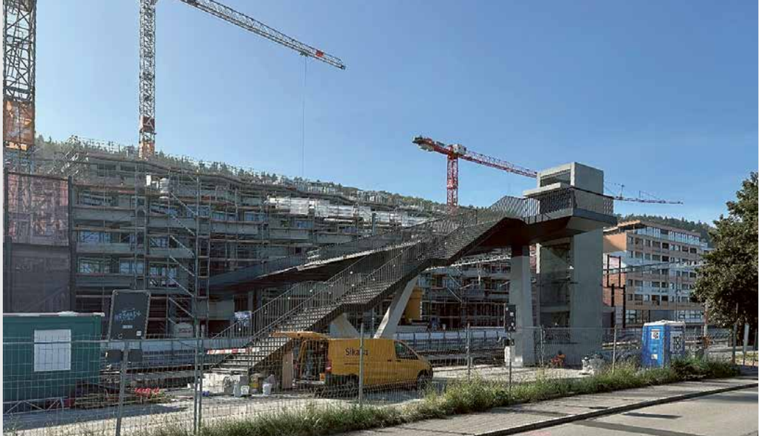
Passerelle beim Bahnhof Horgen Oberdorf im Bau
