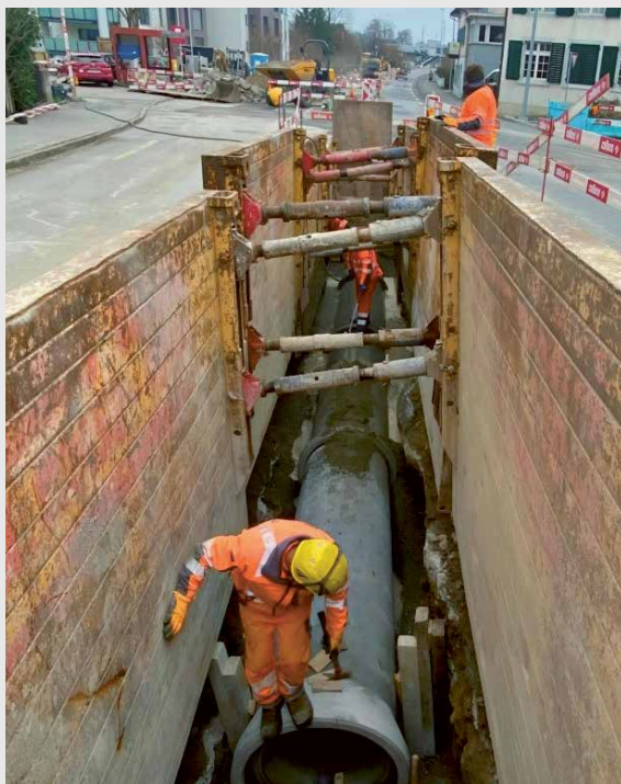
Bauarbeiten an der Mischabwasserkanalisation in der Seestrasse
