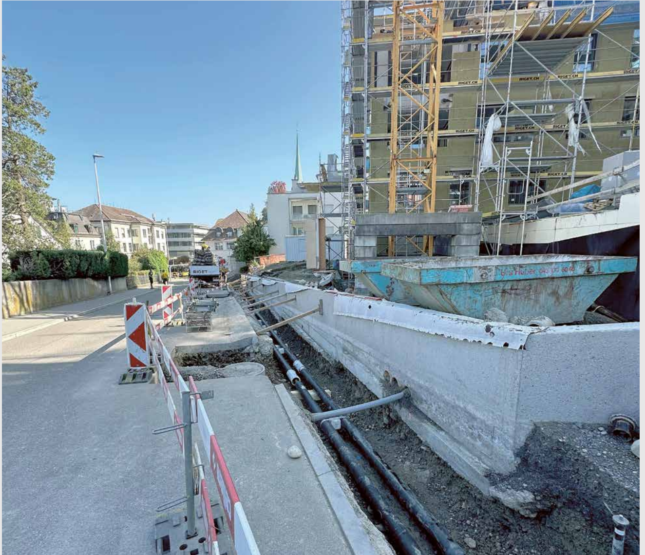
Trottoir- und Verkleitungsbau an der Stocker- strasse
