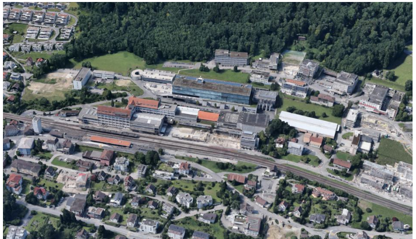
Bahnhof Oberdorf: Neuer Siedlungsschwerpunkt. Hier voll- zieht sich ein Wandel vom Industriege- biet zum Wohn- und Arbeitsplatzgebiet.
