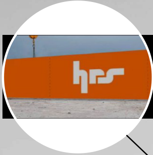
Kunststoff- Doppelsteplatten ausgefachter Bauzaun
