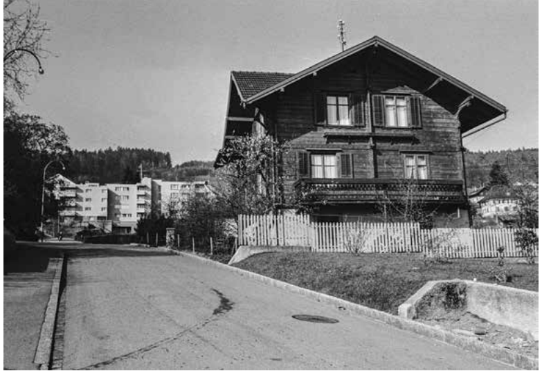
Ehemals Asylstrasse 16 (2006 abgebrochen für den Bau des Tertianums), 1971.
