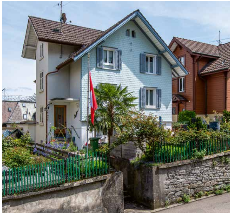
Zugerroseweg 7. Rechts im Bild: Chalet am Zugerroseweg 5, 2023.
