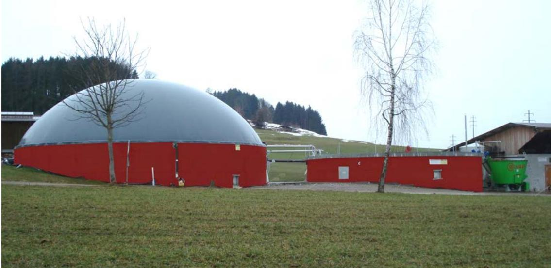
Bild 7: Landwirtschaftliche Biogasanlage mit Fermenter und Nachgärer mit Gasspeicher (Engeli Engineering).
