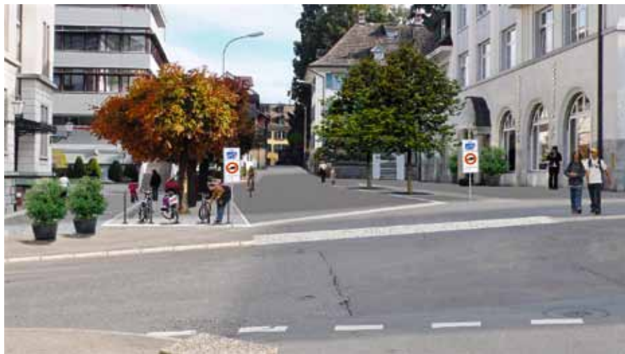
Abb. 4: Einfahrt zur neuen Begegnungszone Zentrum /Abschnitt 1
