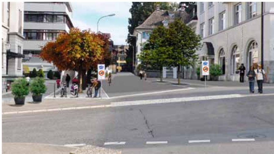
Abb. 4: Einfahrt zur neuen Begegnungszone Zentrum /Abschnitt 1
