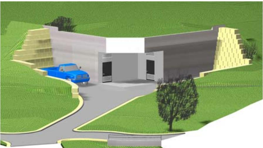
Das geplante Reservoir/Pumpwerk mit Trafostation wird erdüberdeckt und begrünt
