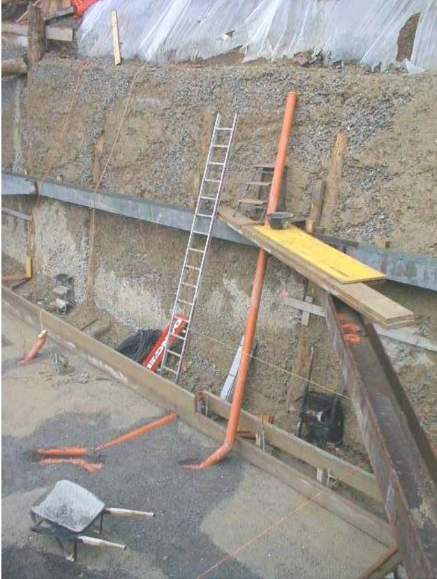
Standrohr mit einer Höhe von 5m um einen Druck von 50 kPa (0.5 bar) Wassersäule zu erhalten.
