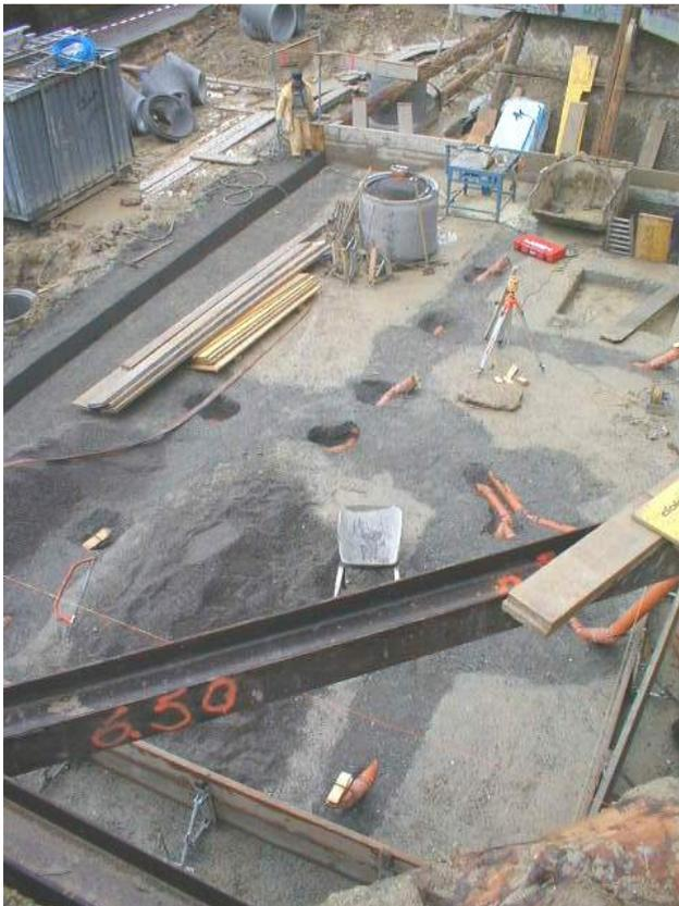
Für die Dichtheitsprüfung werden Muffenstellen zur Überprüfung bei Wasserverlust offen gelassen.
