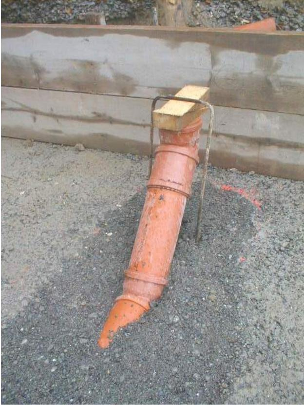
Damit der Deckel durch den Wasserdruck nicht herausgedrückt wird, ist es von Vorteil ein Bügel aus Alteisen in den Magerbeton einzubauen.
