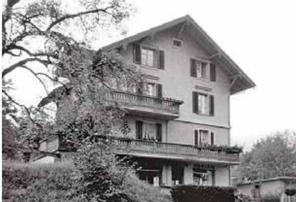
Ehemaliger Konsum an der Heubachstrasse 34, 1962.
