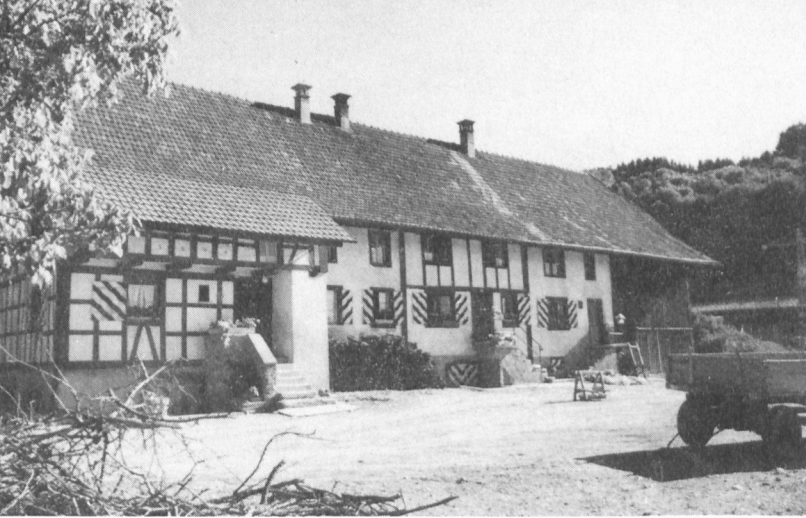
Das Dreisässenhaus «Alte Bocken» ist ein Flarz-Bau, zu dem ursprünglich drei verschiedene Bauerngüter gehörten. Der vorderste Teil trägt die Jahreszahl 1644.
