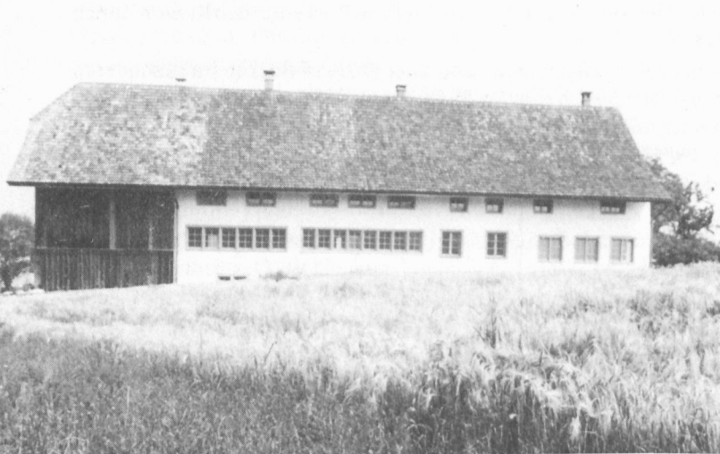
Die Südseite dieses ältesten Hauses auf Bocken, Aufnahme vom Sommer 1984, während der Renovationsarbeiten
