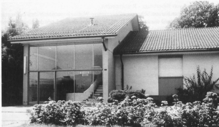
Seewasser- Aufbereitungswerk im Hirsacher
