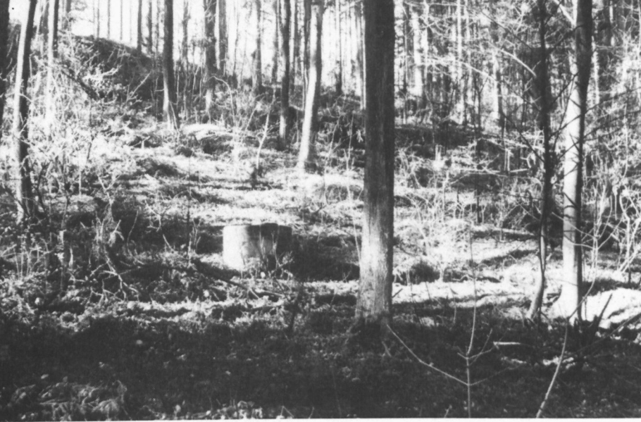
Eine der Brunnenstuben im bewaldeten Abhang unterhalb des Klausplätzli
