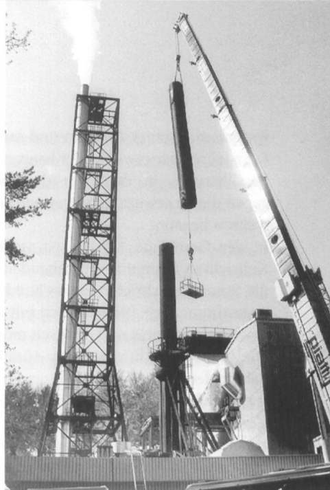
Mit einem Spezialkran wurde die heikle Präzisionsarbeit besorgt.
