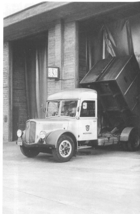
Entleerung eines Kehrichtwagens. Der Plastikvorhang über dem hochgestellten Wagenkasten dient dazu, den entstehenden Staub zurückzuhalten.
