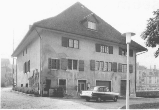
Mit dem See im Rücken des Betrachters: Die Sust vor und nach der Renovation
